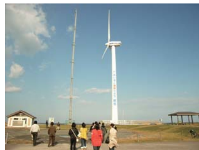
● 上越市風力発電施設
