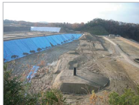
写真2：富山市にある管理型最終処分施設の視察。本学から出た粗大ゴミは焼却などの処理を経たあとで、ここに運ばれ最終処分されています。
