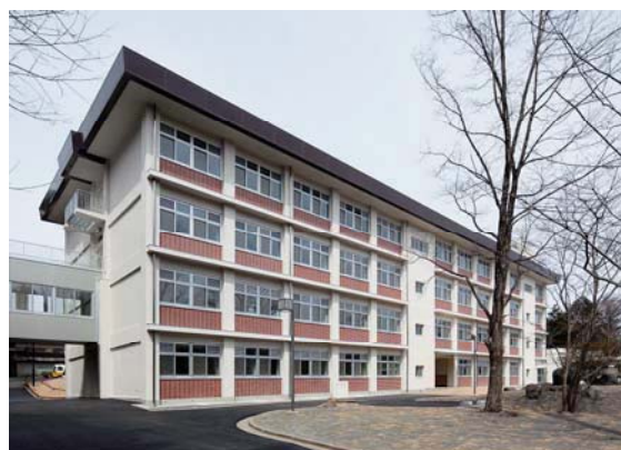
森林科学科棟及び森林科学科実験棟の改修(南箕輪キャンパス) 耐震補強及び機能改善整備を行いました。
